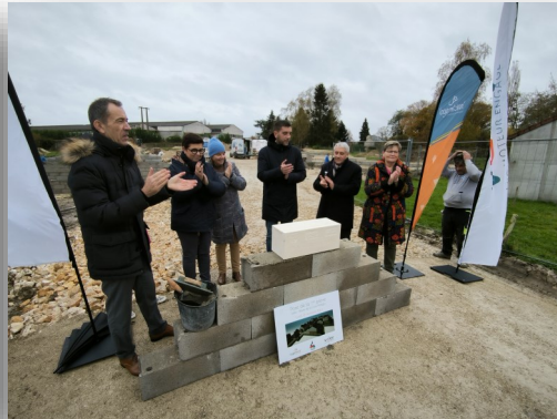
La pose de la première pierre du futur lotissement de 18 pavillons route de la Cour Marigny
